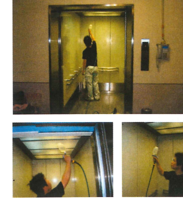
■エレベーター
